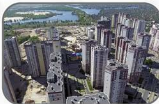
ЖК Патріотика, м.Київ. Системи опалення, холодного і гарячого водопостачання
