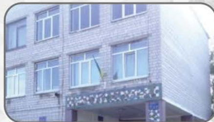
Школа №280, м.Київ, вул.Євгена Харченка,23-Б. Модернізація систем опалення, холодного і гарячого водопостачання
