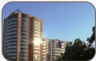
Мікрорайон Леваневського, м.Біла Церква. Модернізація систем опалення та водопостачання
