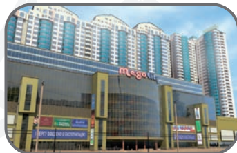
ЖК Мегасіті, м.Київ. Нові системи опалення, холодного і гарячого водопостачання
