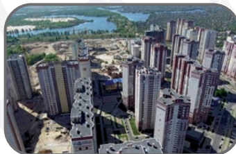
ЖК Патріотика, м.Київ. Системи опалення, холодного і гарячого водопостачання
