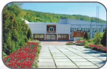
Школа №5, м.Обухів, вул. Лермонтова, 24. Модернізація систем опалення, холодного і гарячого водопостачання
